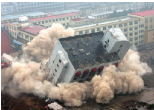
图7-17 利用炸药爆破拆除楼房
