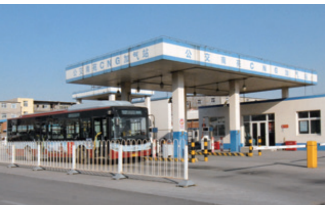
图7-38 压缩天然气汽车加气站
