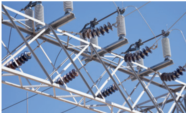
图 5-20 高压输电线路使用了陶瓷绝缘材料
