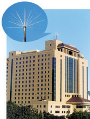
图19.3-5 现代建筑上的避雷针
