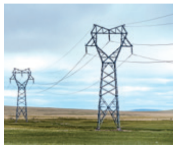
图19.3-6 高压输电铁塔最上面有两条防雷的导线
