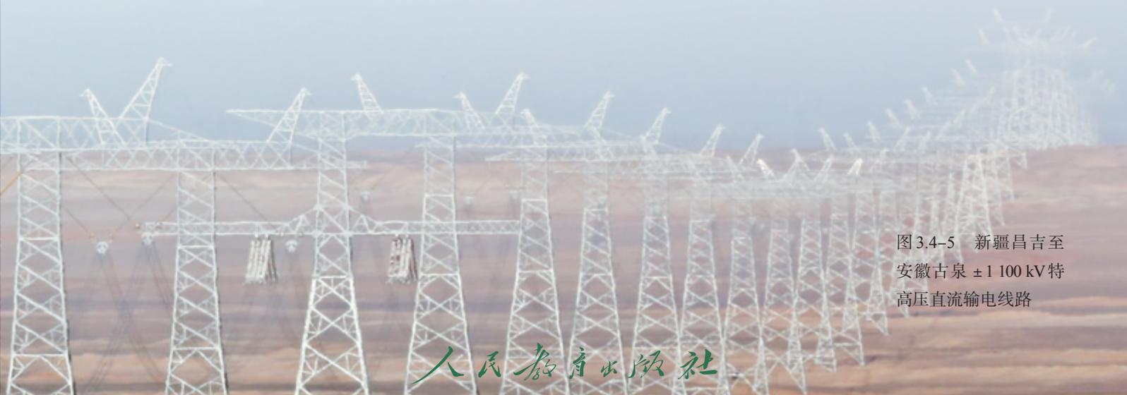
图 3.4-5 新疆昌吉至安徽古泉  $\pm 1100$  kV 特高压直流输电线路
